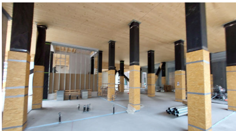
Søjler i limtræ, formonterede stålbeslag og gulve og lofter i CLT Foto: CLT Denmark
