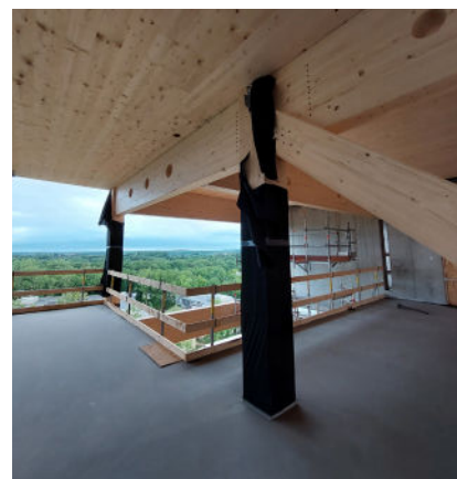
Søjler i limtræ, formonterede stålbeslag og gulve og lofter i CLT Foto: CLT Denmark
