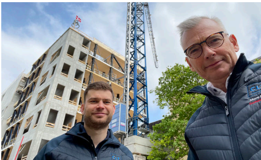
DTUs Climate Challenge Laboratory anvender CLT og limtræ som konstruktionsmateriale. På billedet ses projekteringschef Andreas Juul Larsen (tv) med direktør Per Thomas Dahl foran de syv etager i CLT. Foto: CLT Denmark
